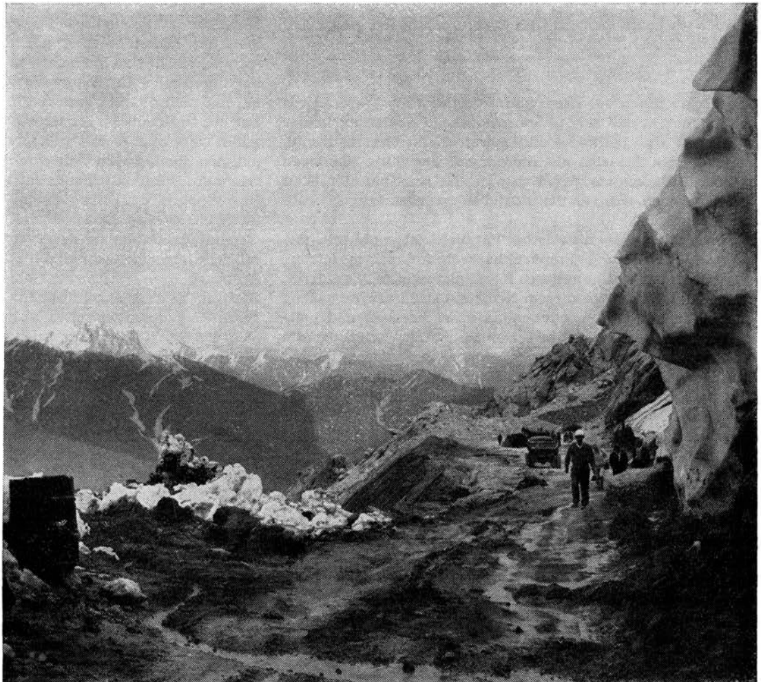
Auch dies ein Bild vom Bau der Asiatischen Fernstraße. Enorme Schwierigkeiten durch gewaltige Höhenunterschiede, riesige Ströme und unterschiedlichste Klimazonen sind zu überwinden. (Siehe Beitrag S. 75 ff. und die Bilder S. 76 und 85.)
